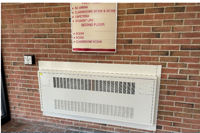
Vestibule Unit Ventilator
